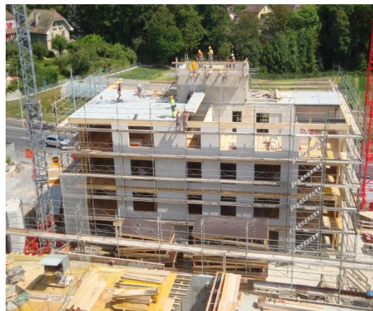
Le premier bâtiment en cours de construction
