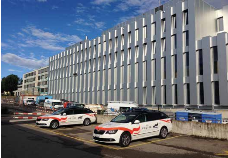
Le nouveau bâtiment administratif de la police cantonale de Fribourg à Granges-Paccot
